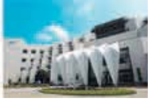
台南研發中心 (鑽石級綠建築)
